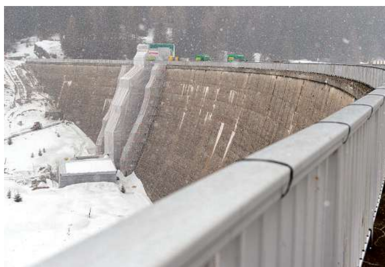
An der 290 Meter langen und 45 Meter hohen Staumauer Isola wird gebaut – die Bauarbeiter entfernen ein Stück Mauer. (FOTO OLIVIA AEBLI-ITEM)
